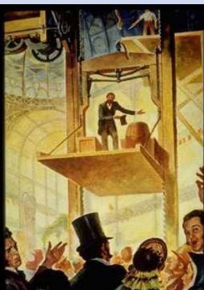
Elisha Otis – představení vynálezu bezpečnostní brzdy na výtahu z r. 1853
