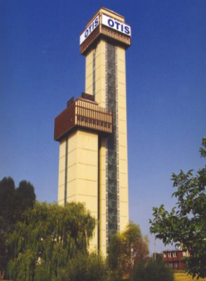
OTIS Břeclav - výtahová testovací věž, výška 80m
