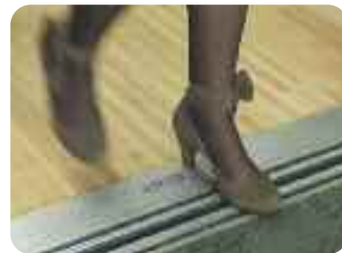
Précision d'arrêt de la cabine au palier +/- 3mm.
