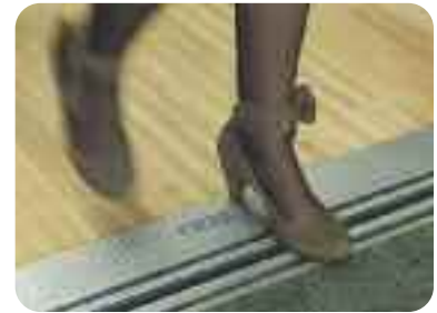
Stopnauwkeurigheid binnen de +/- 3mm
