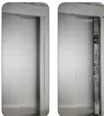
Geïntegreerd schakel- en besturingspaneel. (geopend)
