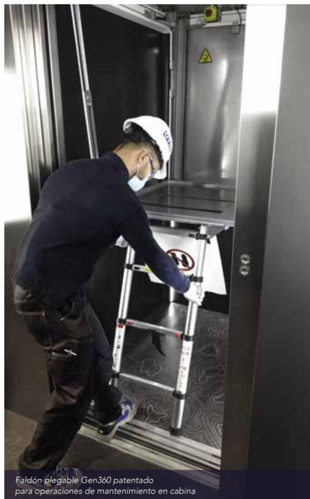
Faldón plegable Gen360 patentado para operaciones de mantenimiento en cabina
