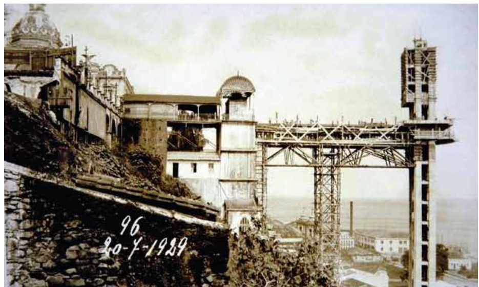
Início da construção da segunda torre do Elevador Lacerda.
