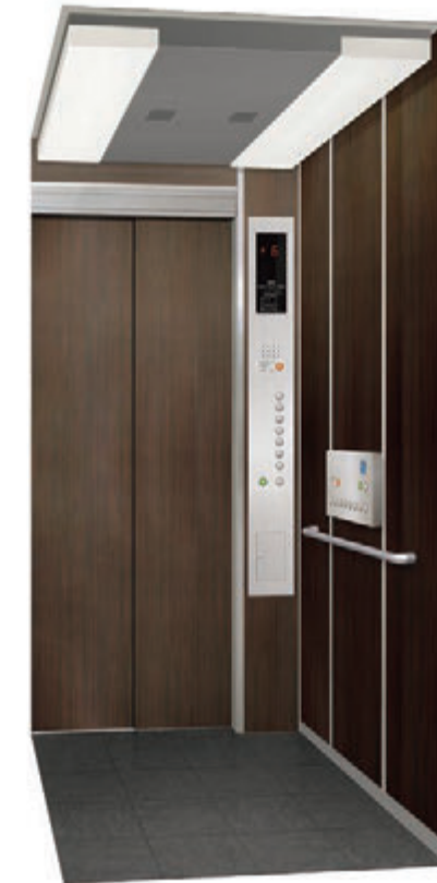
床タイル：ビニルタイル貼替
