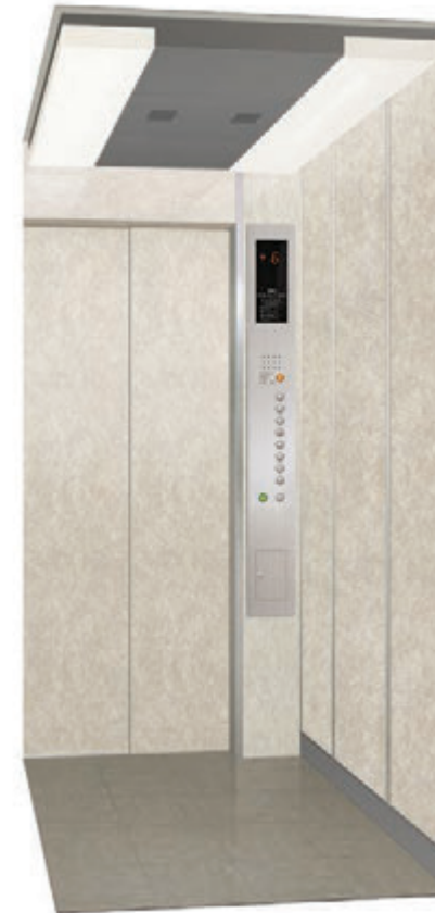
かごパネル：化粧シート貼替 床タイル：ビニルタイル貼替
