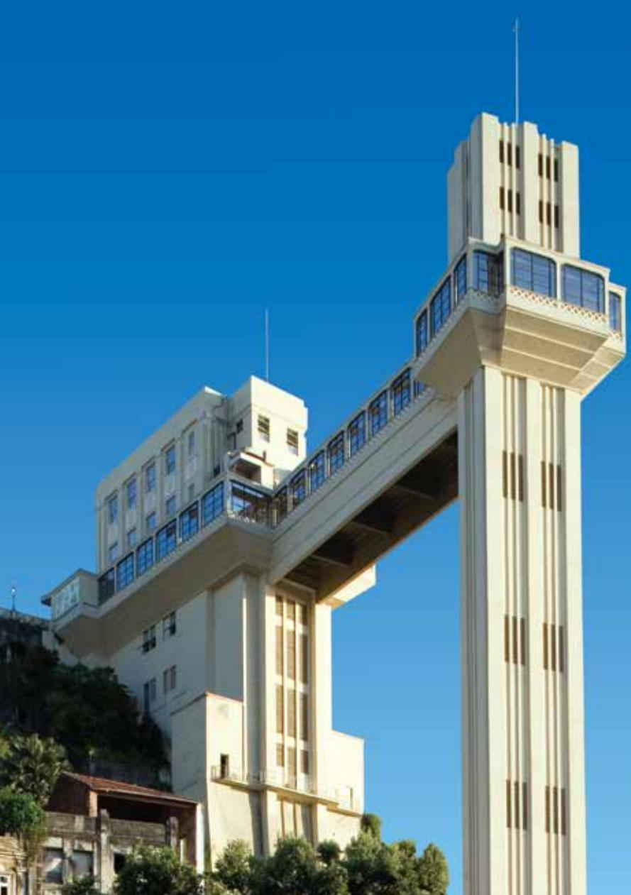
Com o crescimento da cidade, em 1960 foi realizada a substituição das cabinas modernizadas em 1907, sendo a Otis a escolhida para fornecer dois novos elevadores. Em 1987, a Otis modernizou novamente os elevadores da 2ª Torre, instalados em 1930, aproveitando apenas as máquinas, os geradores e as guias.
