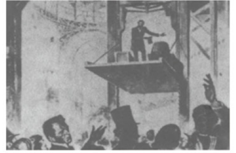
ELISHA GRAVES OTIS가 1852년에 안전승강기를 발명하고 1853년에 OTIS ELEVATOR회사를 설립했다. 1년뒤 뉴욕의 CRYSTAL PALACE에서 그가 발명한 승강기의 안전을 대중앞에 증명해 보였다. 군중이 지켜보는 가운데 높이 올라간 승강기 로프를 끊어도 추락하지 않는 것을 보여주어 안전승강기의 시대를 열었다.
