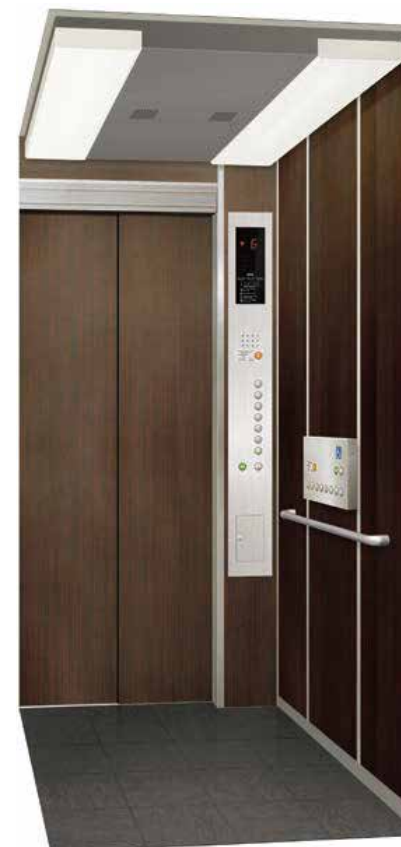
床タイル：ビニルタイル貼替
