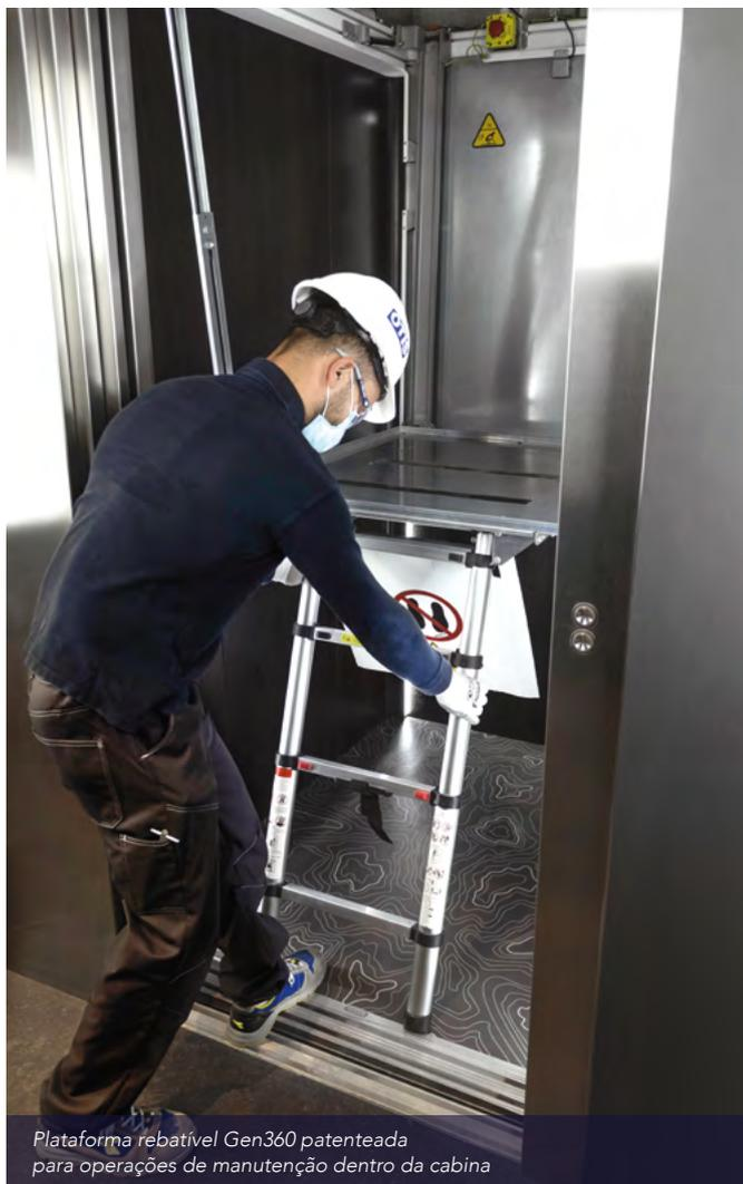
Plataforma rebatível Gen360 patenteada para operações de manutenção dentro da cabina
