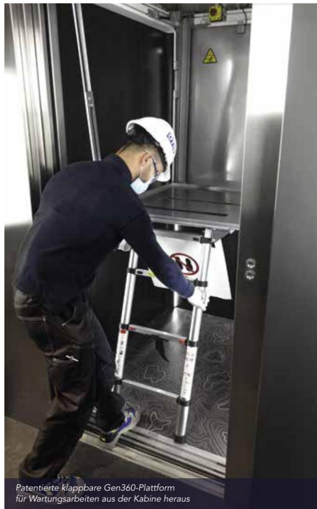
Patentierte klappbare Gen360-Plattform für Wartungsarbeiten aus der Kabine heraus
