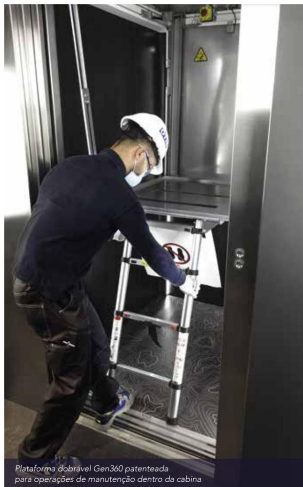
Plataforma dobrável Gen360 patenteada para operações de manutenção dentro da cabina
