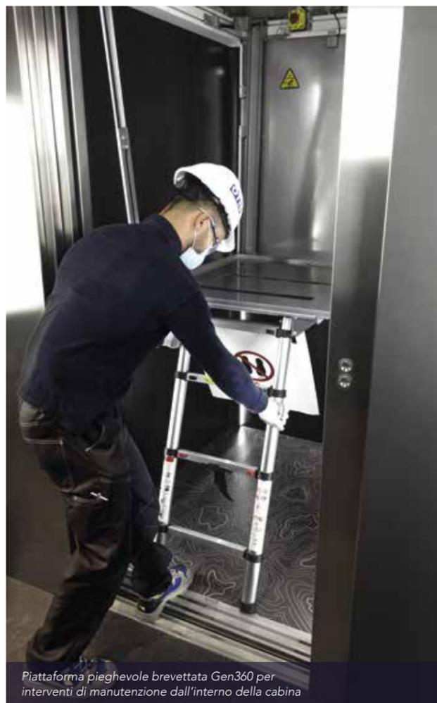
Piattaforma pieghevole brevettata Gen360 per interventi di manutenzione dall'interno della cabina
