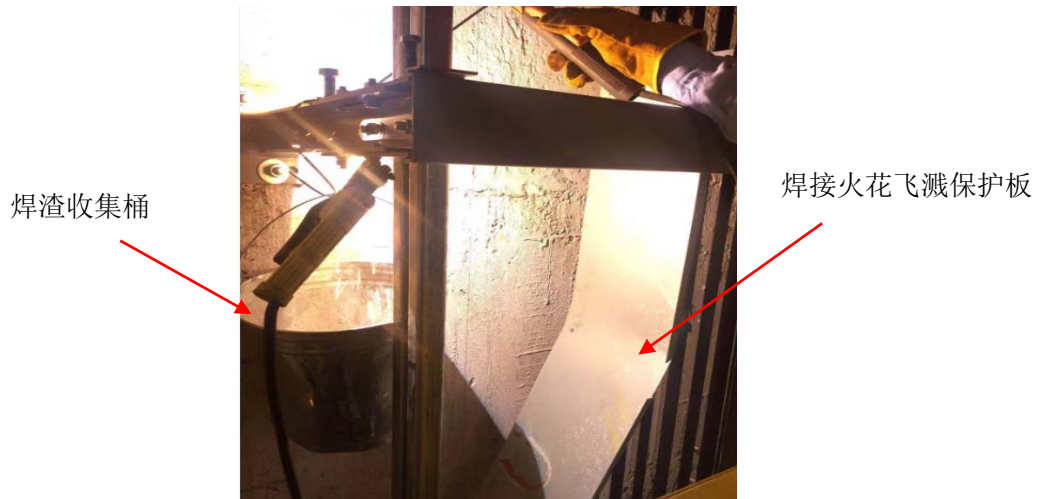
焊接火花或焊渣保护工具的实例
