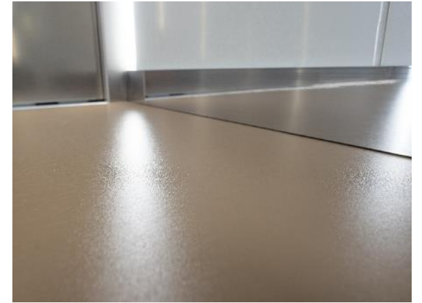
Protezione dagli urti e pavimento in gomma antibatterica
