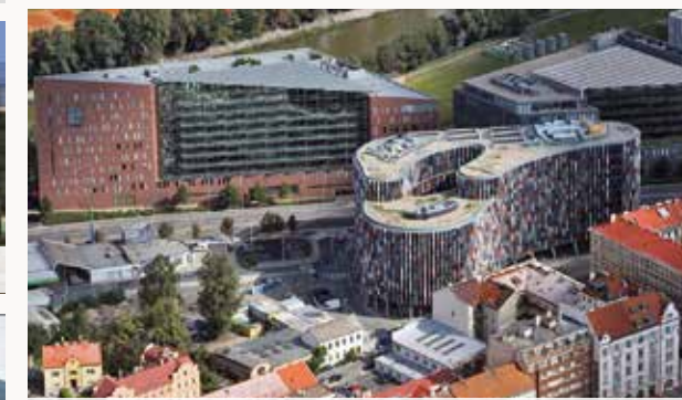
Administratívne centrum River City a Main Point Karlín, Praha
