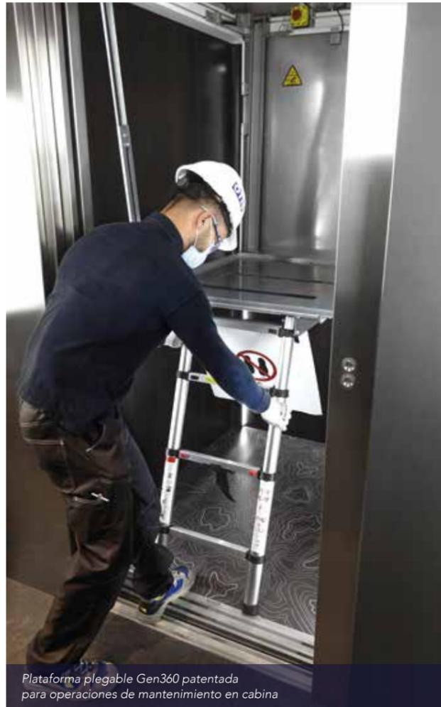
Plataforma plegable Gen360 patentada para operaciones de mantenimiento en cabina
