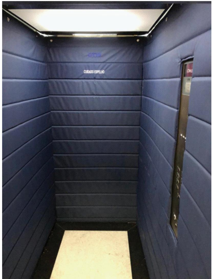
Imagem do protetor acolchoado instalado
