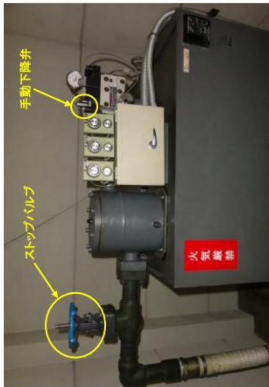
閉じ込め時の乗客の救出 太陽鉄工 TCM 製バルブ
