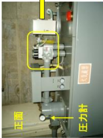
閉じ込め時の乗客の救出 EV2-M5846 制御弁 (TAIYO)
