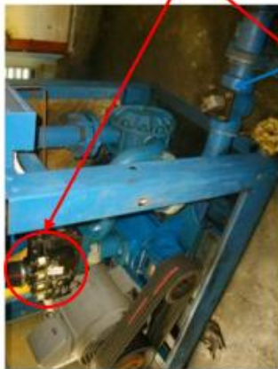
閉じ込め時の乗客の救出 東洋ハイドロ製油圧バルブ
