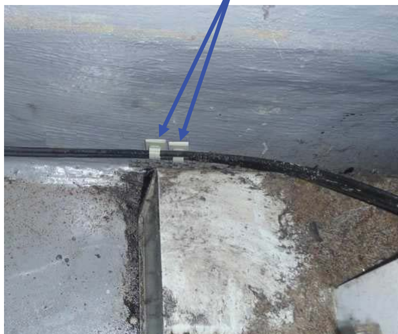
ナイロンステッカーでワイヤーを固定
