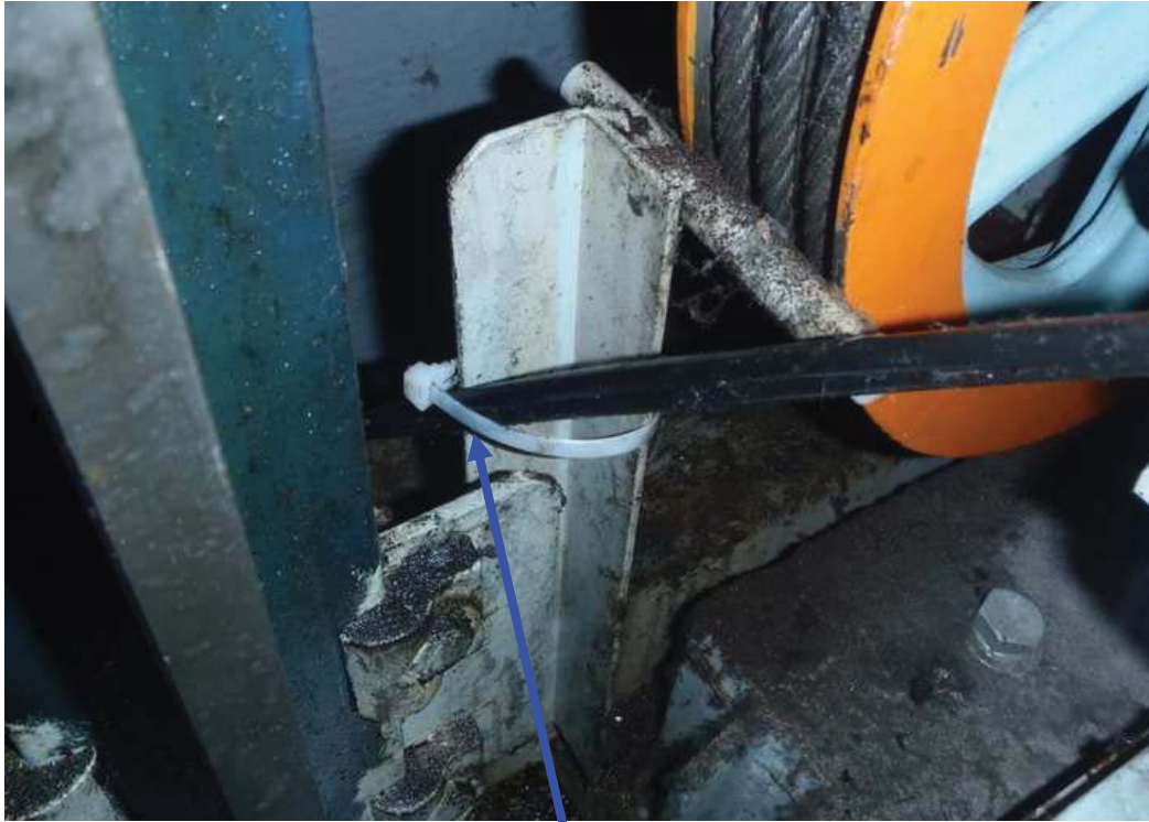
ロープ外れ止めにワイヤーを固定
