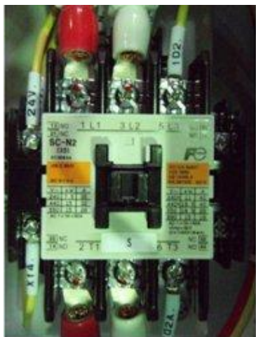
電磁接触器(S1,S2,VC1) (サイズは物件毎に異なる)
