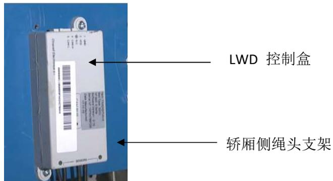
注：装置离最远的传感器允许的最大距离为 420mm
