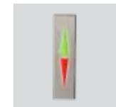
Fahrrichtungsanzeiger im Inneren der Kabine
