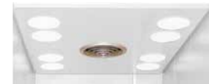
天井既存例 (化粧シート貼付)
